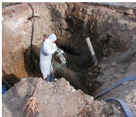
Estas redes además, debido al tiempo transcurrido desde su instalación, **cada día que pasa se encuentran más deterioradas, siendo más propensas a roturas con el consiguiente riesgo de exposición** a la emisión de fibras al ambiente debido a los trabajos de corte y refrentado de tubería, necesarios en las tareas de arreglo y mantenimiento.
