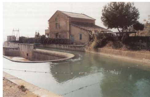
Central Minihidráulica del Canal de Zaidín. Grupo de Electrificación Rural de Binéfar
